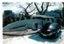
ホンダが埼玉県庁と協力して運営する水素ステーション。屋根に設置した太陽電池による電力で水を電気分解して水素を生成している。
